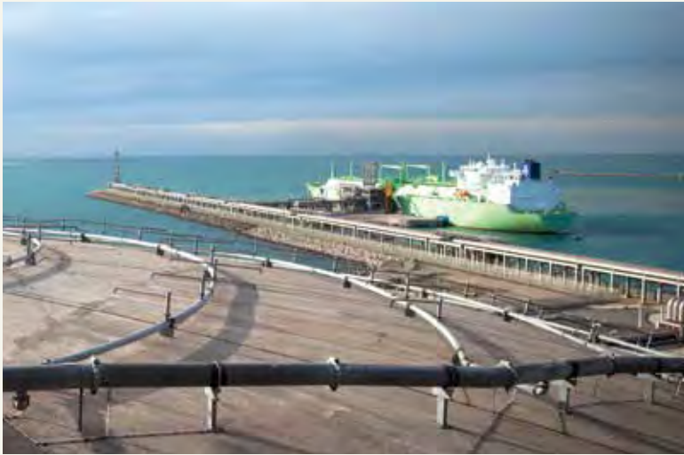
◀ Navire méthanier dans le terminal de Fos Cavaou.
