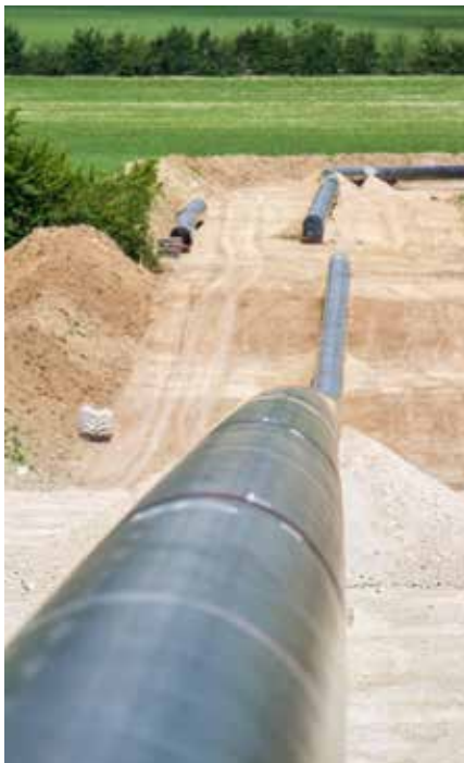
Chantier de l'Arc de Dierrey. Le projet Arc de Dierrey, canalisation d'environ 300 km, entre Cuvilly (60) et Voisines (52), permettra d'acheminer vers l'est et le sud de la France le gaz naturel reçu par le terminal méthanier de Dunkerque.
