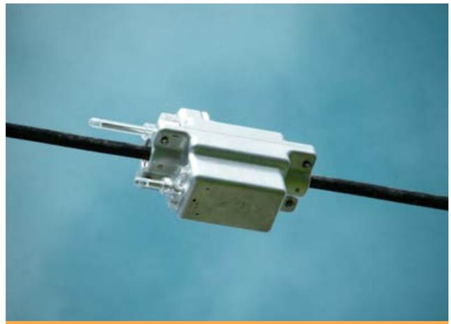
*Capteur utilisé dans le cadre du dynamic line rating.*
