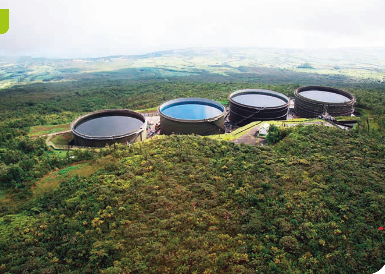
RÉSERVOIRS DU BARRAGE DE RIVIÈRE DE L'EST, LA RÉUNION (VISITE DE LA CRE, OCTOBRE 2014).
