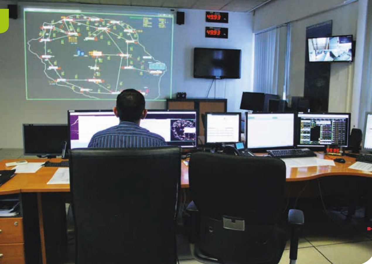
CENTRE DE DISPATCHING EDF À SAINT-DENIS DE LA RÉUNION (VISITE DE LA CRE, OCTOBRE 2014). © CRE
