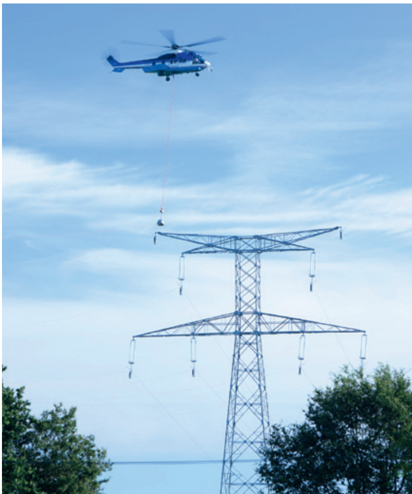
Levage de pylône sur la ligne Cotentin-Maine (52), le 8 août 2012.
