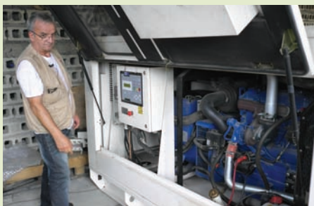
Installation complète de l'infrastructure électrique (280 KWh de puissance) et réalisation de tout l'éclairage de l'hôpital de Médecins sans frontières Suisse à Léogâne.
