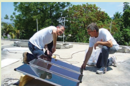
Eclairage photovoltaïque du foyer de la Miséricorde.
