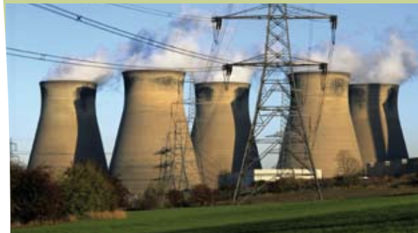
Tours aéroréfrigérantes d'une centrale nucléaire
