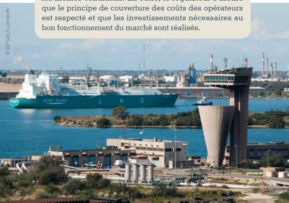
Terminal méthanier de Fos-Cavaou (Bouches-du-Rhône). La CRE a fixé une grille tarifaire pour 4 ans en hausse de 12 % pour ce terminal.
