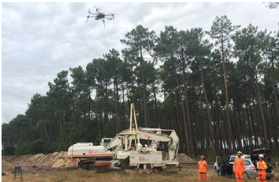
Test de drone sur un chantier TIGF.
