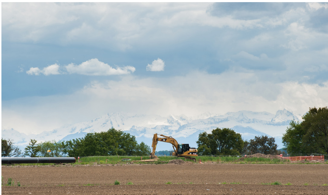
Travaux sur le chantier TIGF de l'Artère du Béarn.
