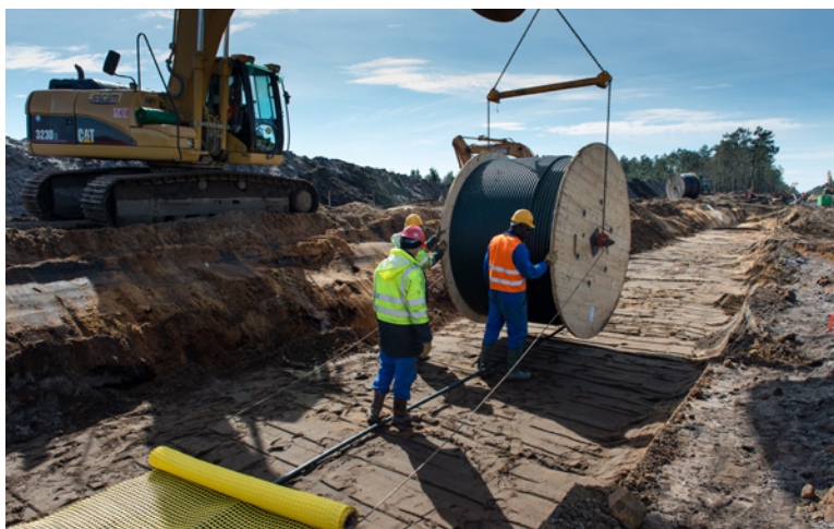
Pose de fibre optique suite à la mise en fouille d'une canalisation de gaz.
