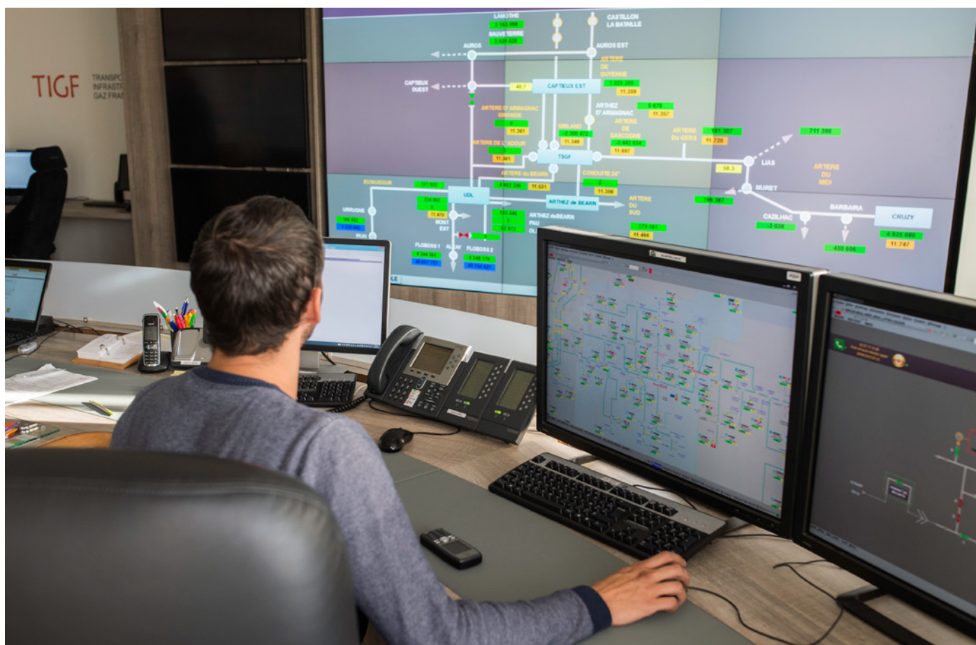
Surveillance du réseau depuis la salle de contrôle de TIGF.
