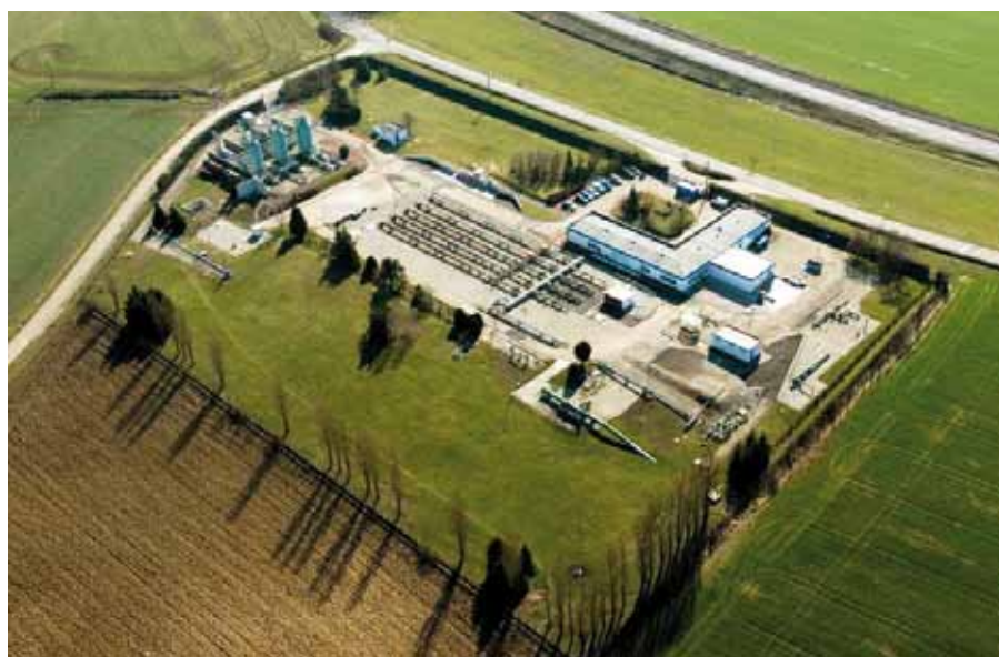
Photo aérienne de la station de réception et de comptage du gaz d'Obergaibach
