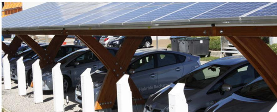
Figure 5 – Ombrières photovoltaïques pour des véhicules électriques (Source : Driv'Eco)
