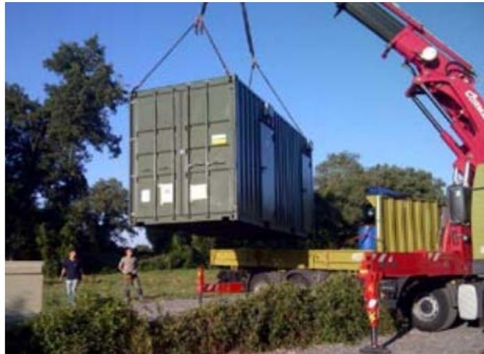
**Figure 10 – Batterie Lithium-Ion d'une capacité de 150 kWh installé dans le cadre du projet IPERD dans la région Poitou-Charentes (Source : SRD)**
