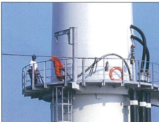
Figure 28 Remontée des câbles au travers des J-Tubes
