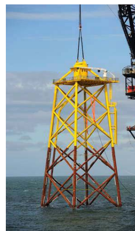
Figure 76 : Différentes fondations pour les éoliennes offshore (Germanischer Lloyd), Jacket (Source : Technip)
