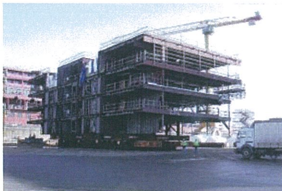
Figure 35 Poste Offshore en cours de transport vers la barge
