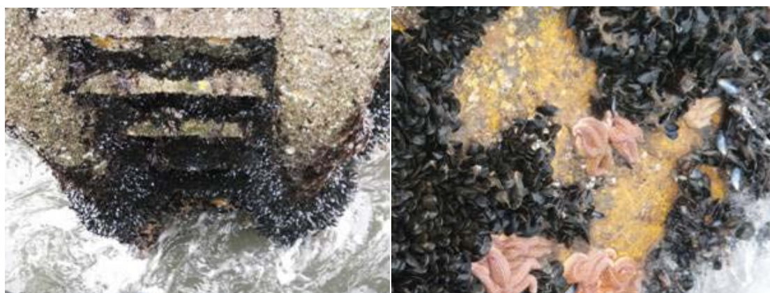
Figure 31 : Colonisation de fondation d'éolienne par des organismes aquatiques
