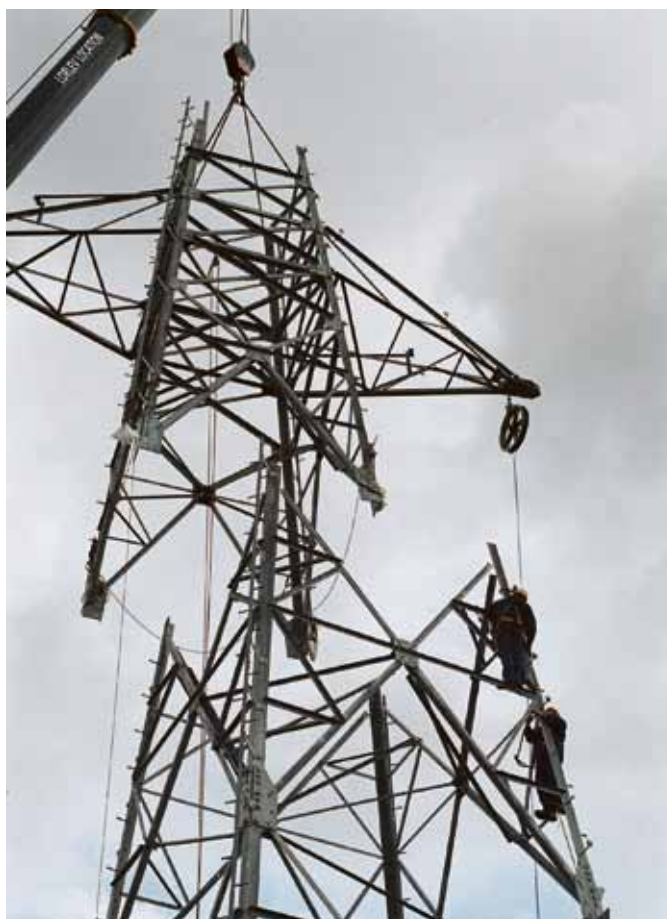
◀ Pose d'un pylône pour la construction d'une ligne 225 000 Volts.
