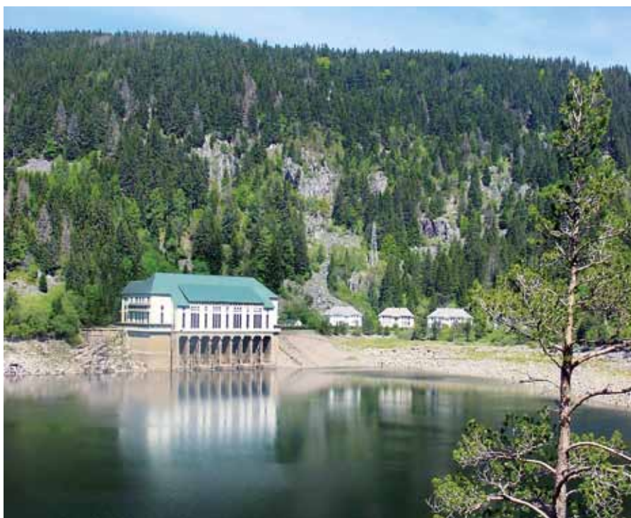
▲ Le Lac Noir, dans le massif vosgien. Un projet de remise en service est en cours pour cette station de transfert d'énergie par pompage (STEP). Sur ce site, le Lac Noir est relié au Lac Blanc (100 mètres plus haut) par une conduite forcée souterraine. Ce système permet la production d'électricité par turbinage aux heures pleines, en alternance avec la recharge du Lac Blanc, par pompage, aux heures creuses.
