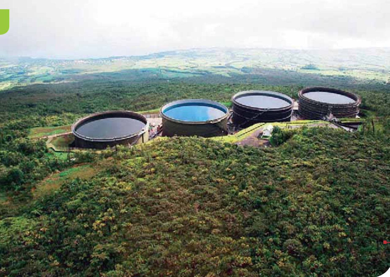
RESERVOIRS OF THE RIVIÈRE DE L'EST DAM, RÉUNION (VISIT OF CRE, OCTOBER 2014).
