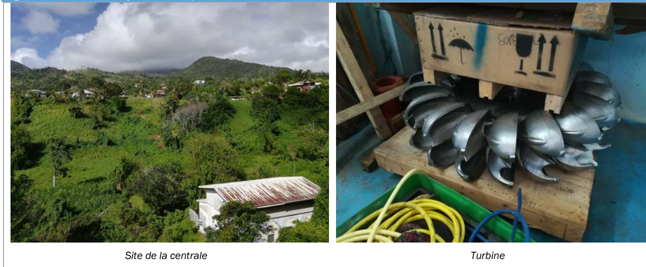
Figure 14 : Centrale hydroélectrique de Bananier
