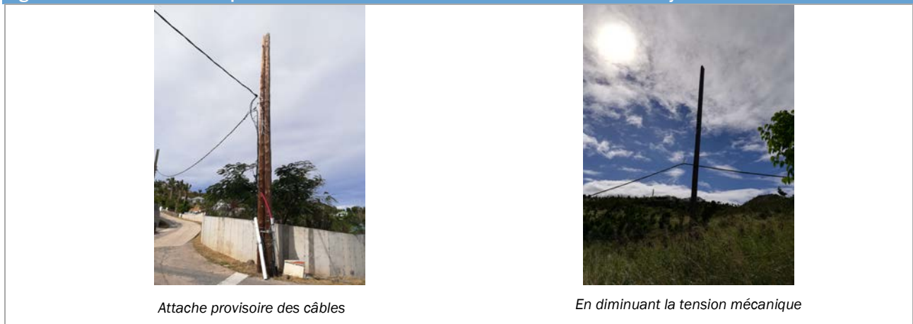
Figure 15 : Illustration des opérations de sécurisation du réseau à Saint-Barthélemy
